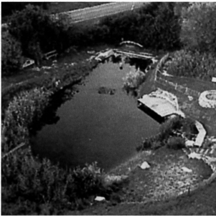
Pflanzenkläranlage mit Schwimmteich
